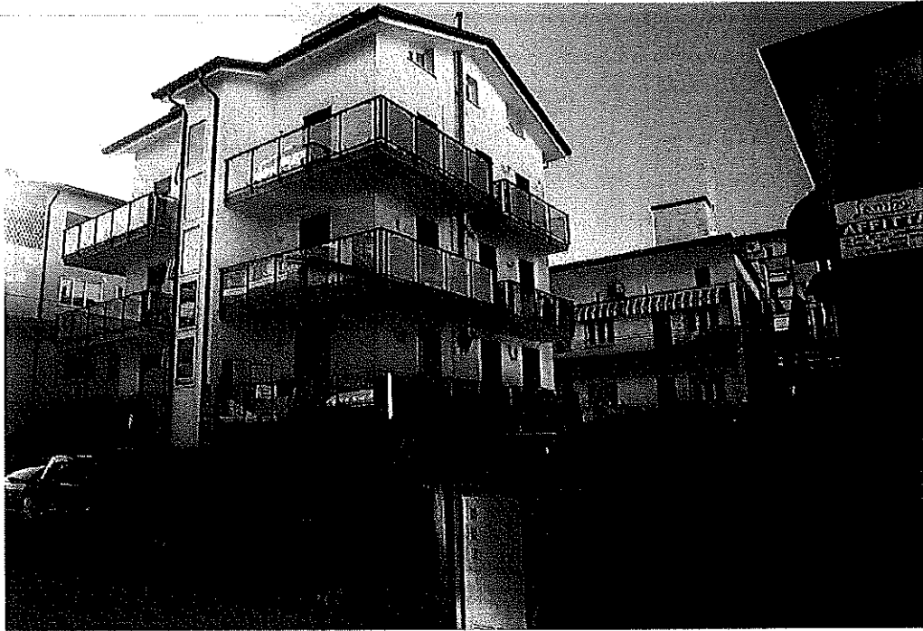
FOTO 3 - L'edificio in esame.
